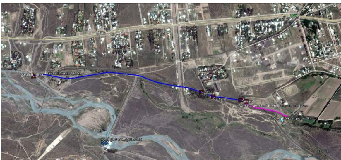
Figura N° 3. Obra Revestimiento, recrecimiento y ensanche.
