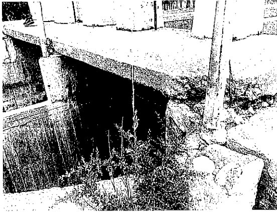
Fotos N°08 y 09: Rotura en la losa de apoyo del tablero
