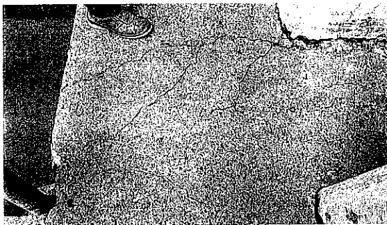
Foto N°10 y 11: Fisuras observadas en el tablero del puente
