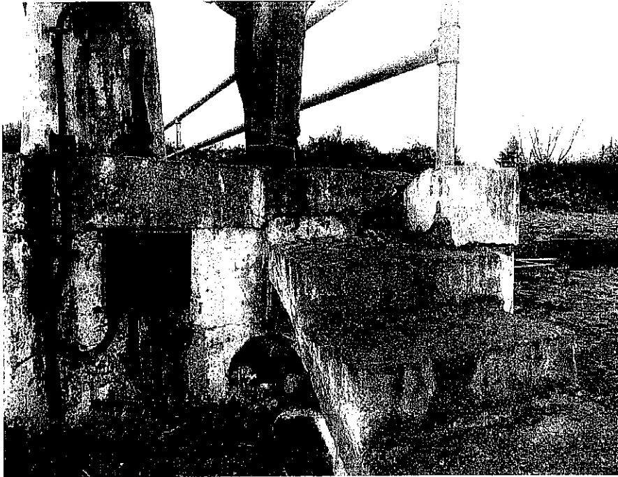
Foto N°06: Losa apoyando sobre estribo (muro lateral)
