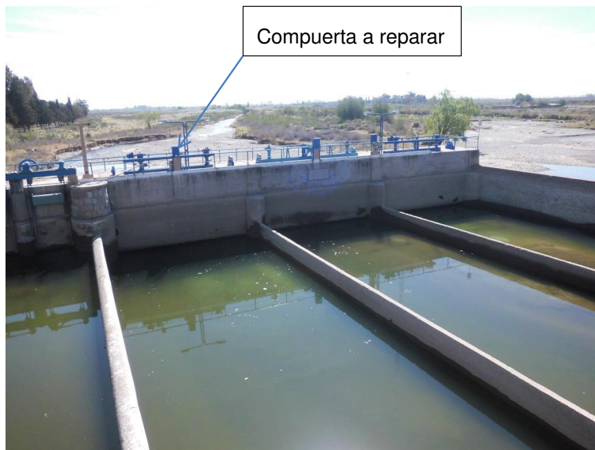
Compuerta N° 5 a reparar
