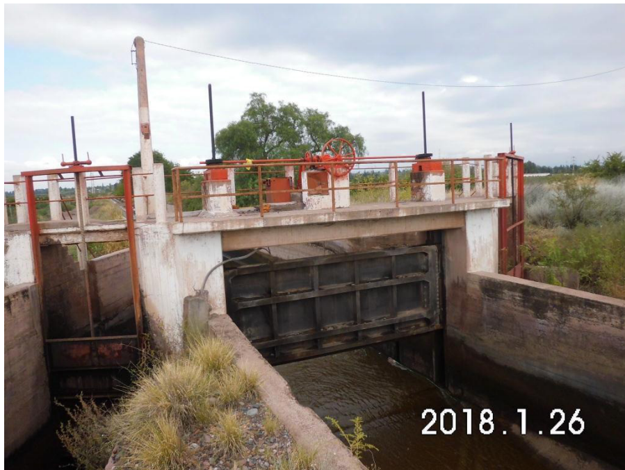
Vista frontal del dique y compuertas a reparar
