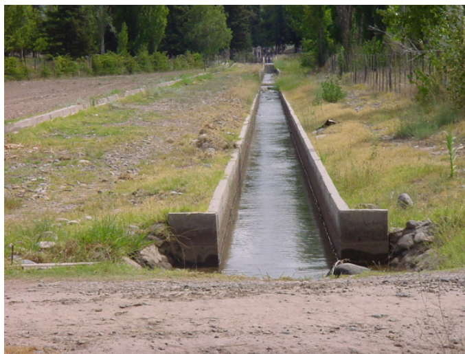
Figura 5. Ubicación de ingreso a reservorio
