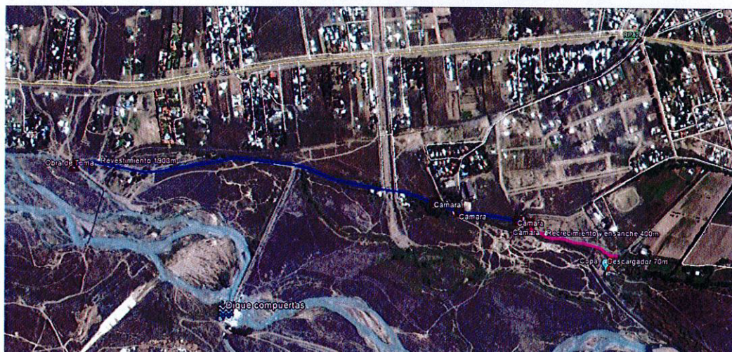
Figura 5 Obra Revestimiento, recrecimiento y ensanche.
