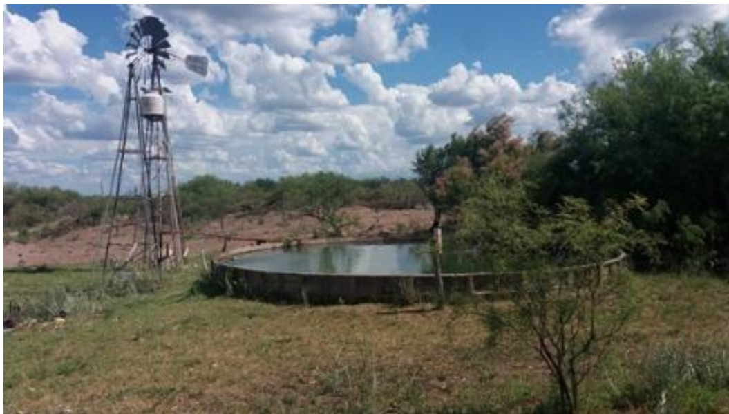
Figura 16. Pileta de almacenamiento de agua
