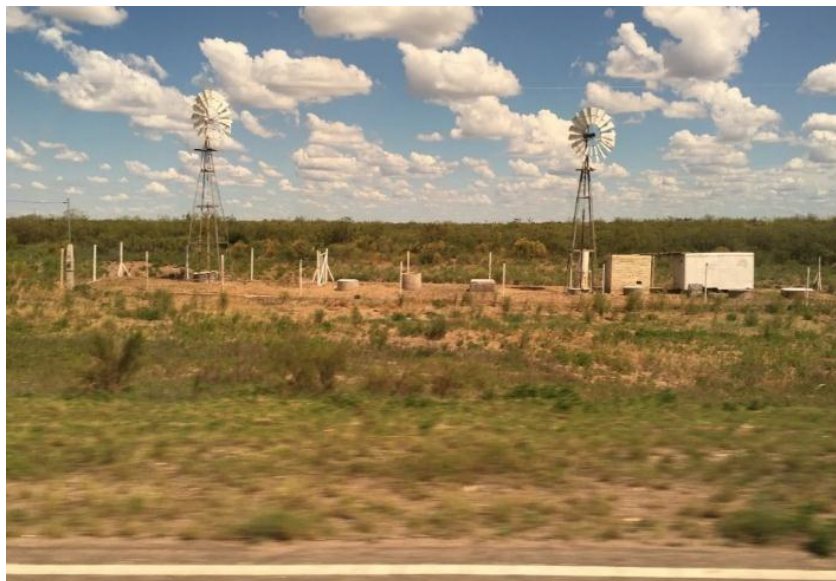
Figura 3. Pozos en la margen Sur RN146.
