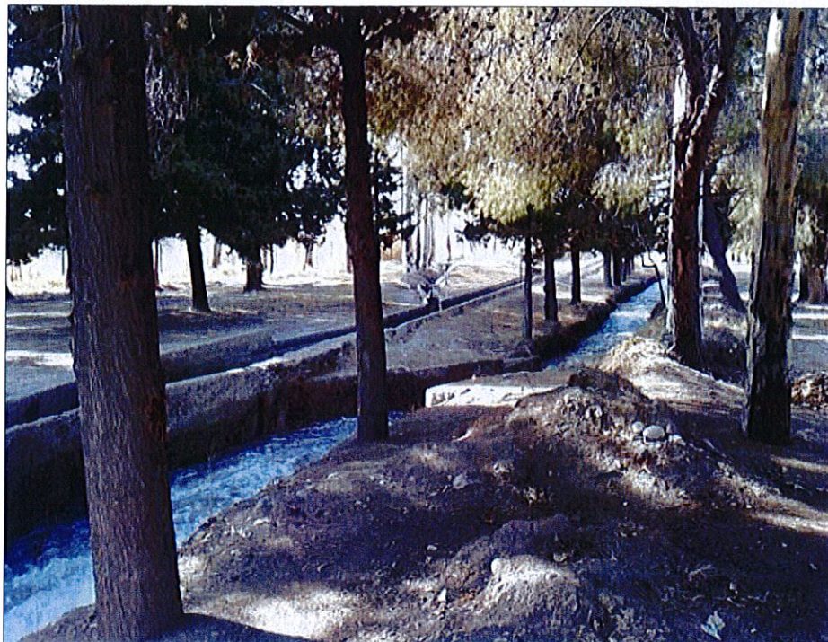
Figura 94. Derivación de accedentes hacia el Canal Céspedes
