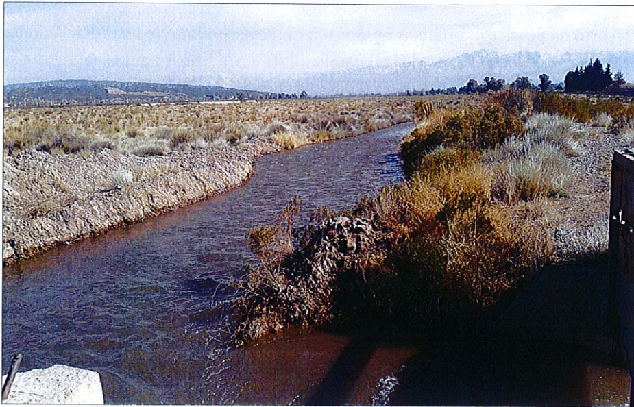
Figura 46. Vista del río Mendoza desde la toma del canal
