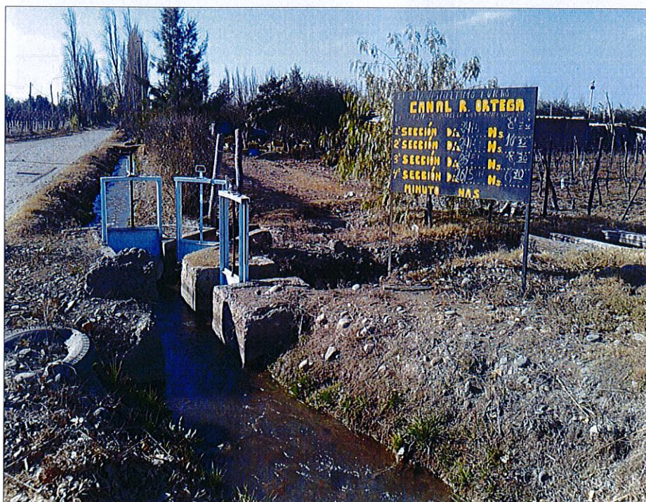
Figura 95. Detalle de la zona bajo riego del Canal Ortega
