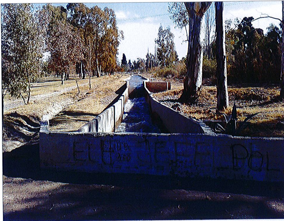
Figura 92. Canal Rufino Ortega vista calle Belgrano hacia el oeste
