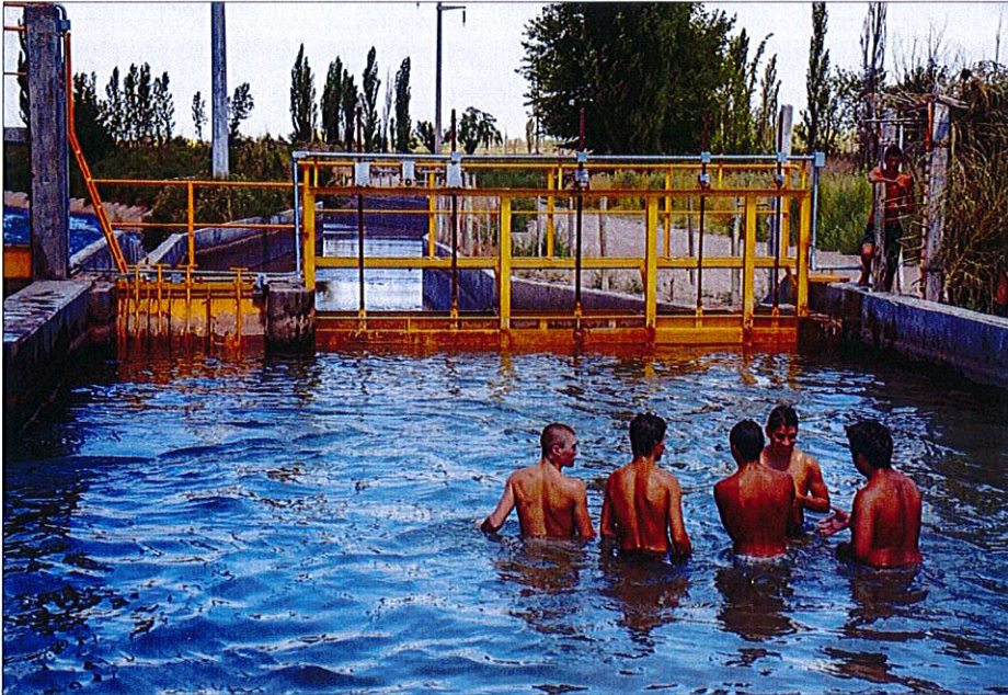
Figura 87. Uso indebido de la infraestructura de riego
