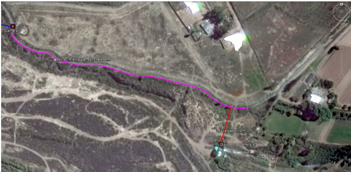
Figura N° 4. Obra de Descarga del canal Compuerta a la copa
