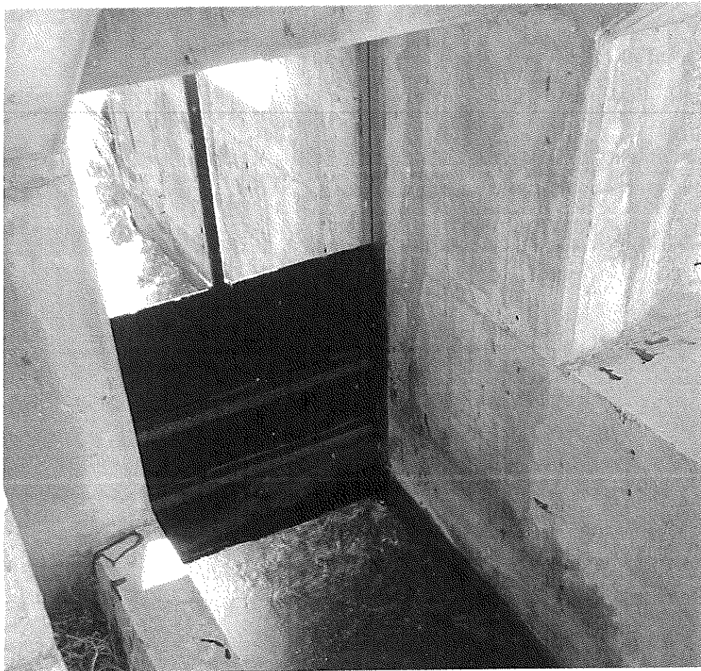
Reparación de compuerta y enderezado de vástago en compuerta Canal Sauce de las Rosas
