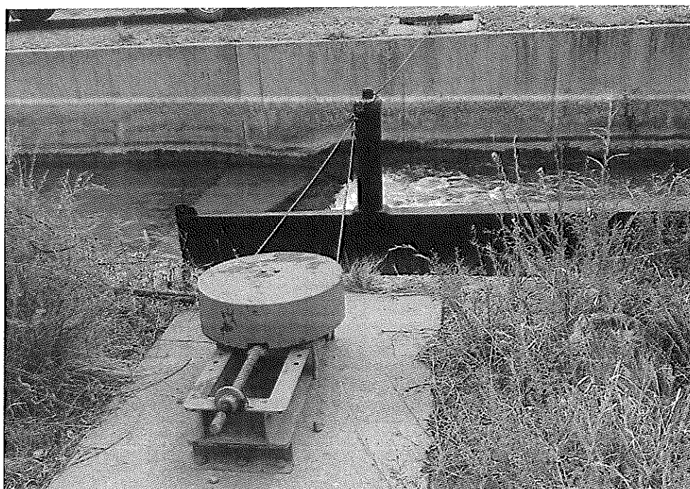
Instalación de mecanismo de operación en Hoja Partidora
