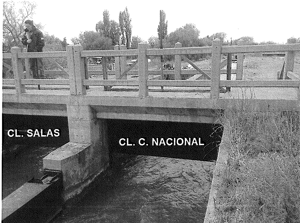
Reparación de ambas compuertas; Canal Salas y Canal Cuadro Nacional
