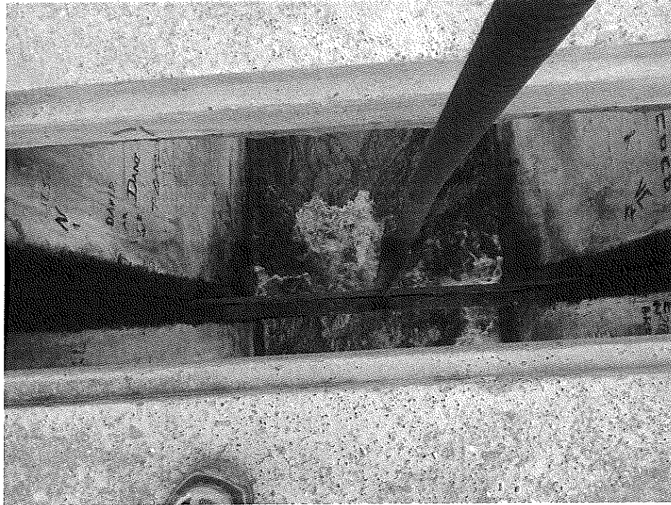
Reparación de compuerta y enderezado de vástago en compuerta Canal Cerrito
