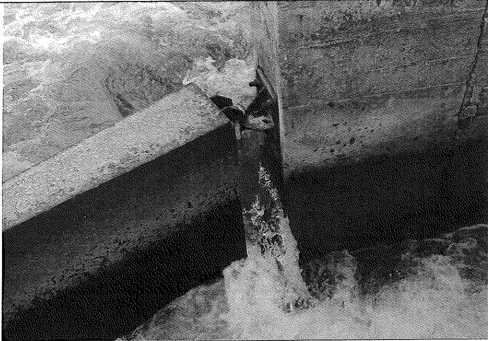
Provisión y montaje de deflectores en hoja partidora para evitar reflujos
