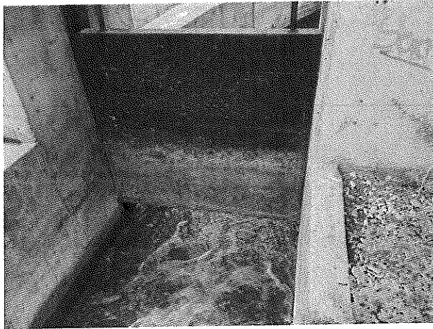
Reparación de compuerta y enderezado de vástago en compuerta Canal Gutierrez - Vila
