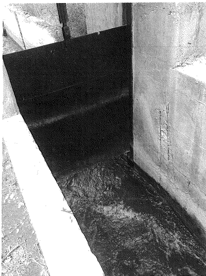
Reparación de compuerta y enderezado de vástago en compuerta Canal Pavez
