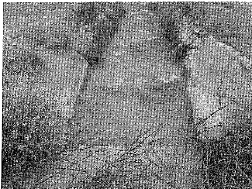
Figura 7 Inicio de Obra Entubado. Se observa la salida del sifón de cruce existente. Canal de tierra.
