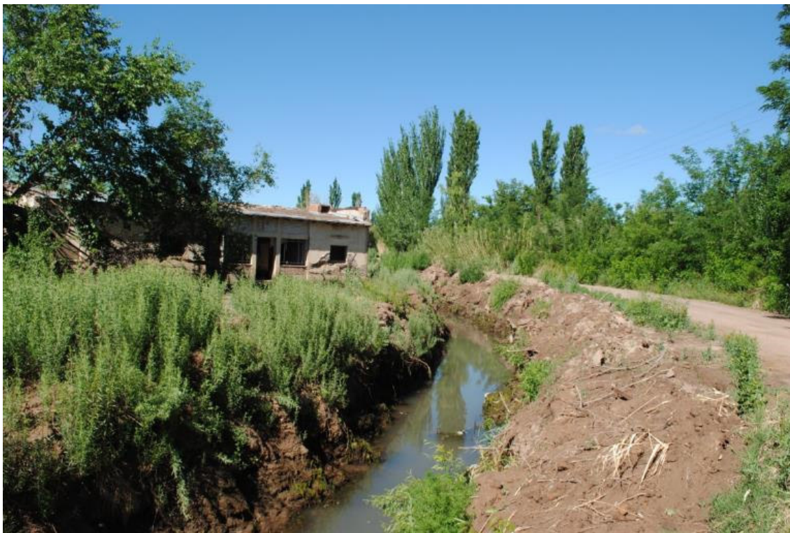
Figura 6 Canal Rama Chimba. Sección sin revestir existente.
