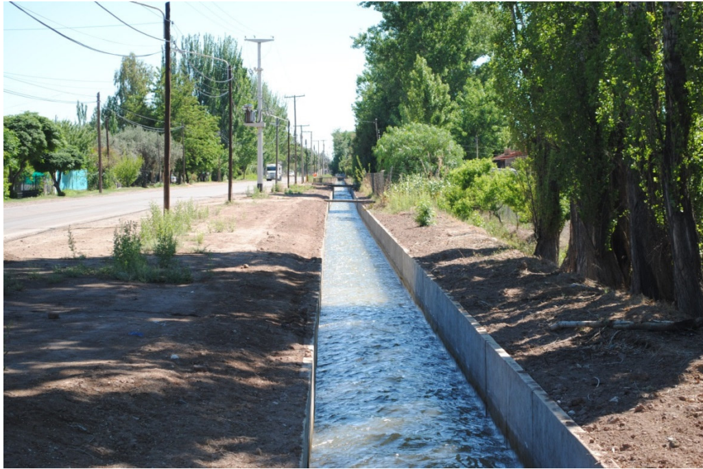
Figura 13 Canal Rama Chimba. Traza revestida existente.
