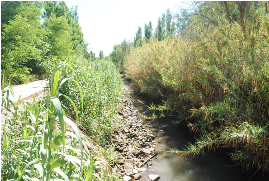
Figura 12 Canal Rama Chimba. Traza sin revestir.
