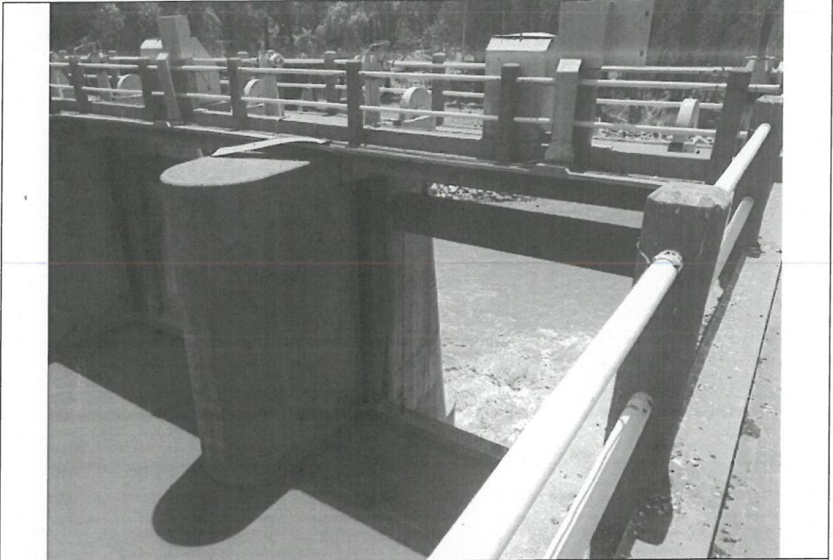
Vástago Torcido de la Compuerta N°1 Azud Móvil.
