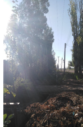
Foto 5: Línea eléctrica próxima al canal
