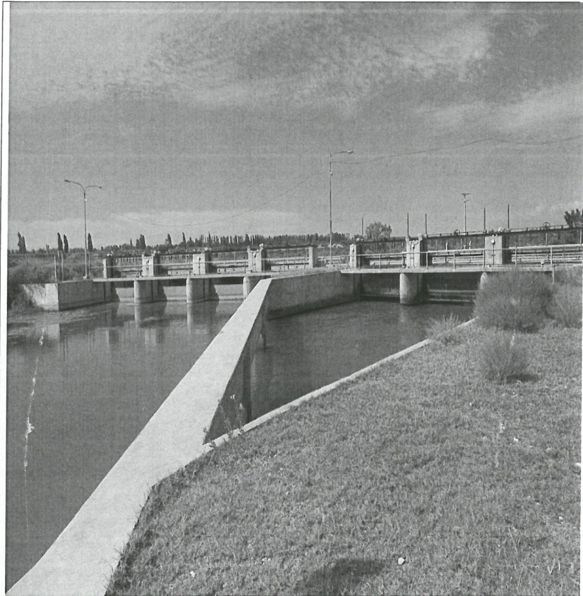
Obra de Toma.
