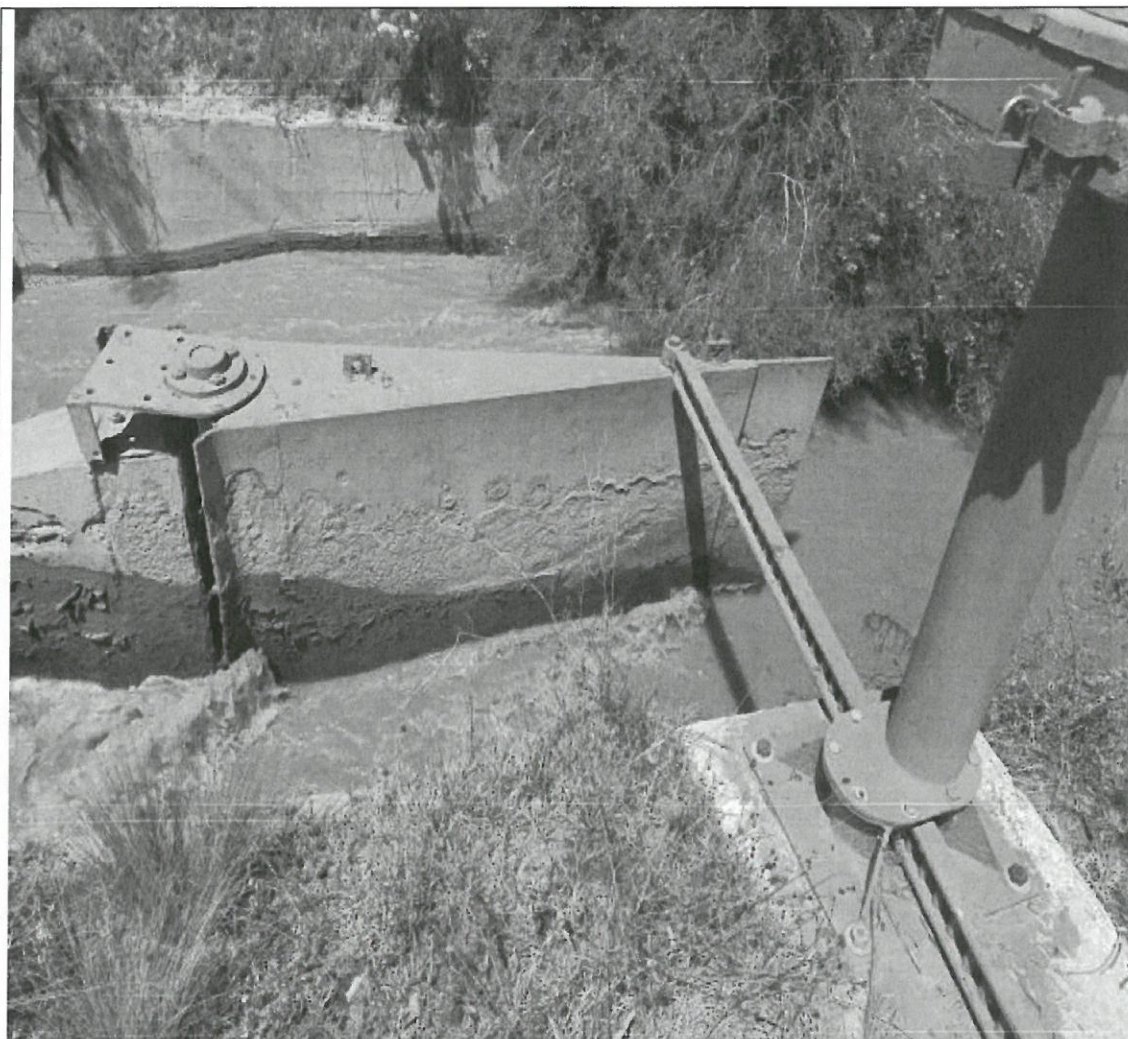
Comparto Vista Flores , compuesto por una hoja partidora, y dos compuertas.
