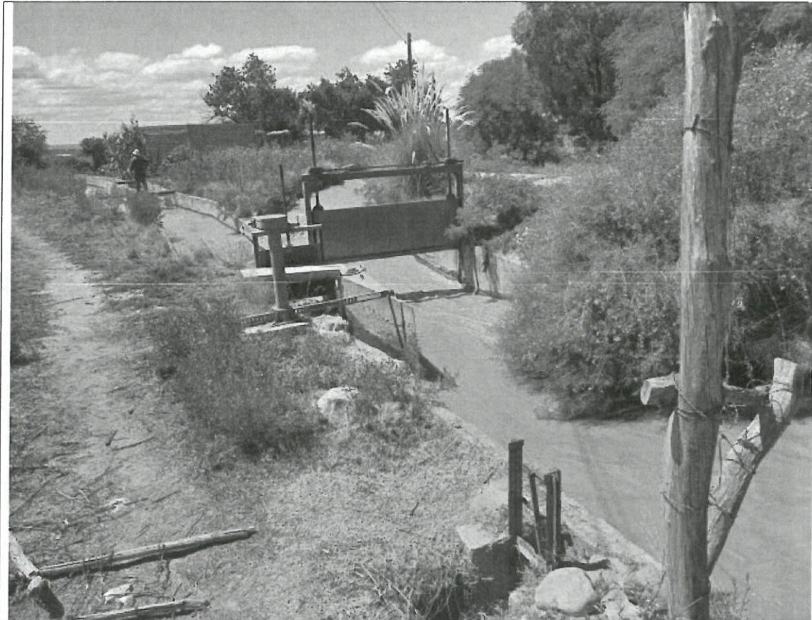
Comparto la Consulta , compuesto por una hoja partidora (Mediana), dos hojas partidoras (Chicas) y dos compuertas.
