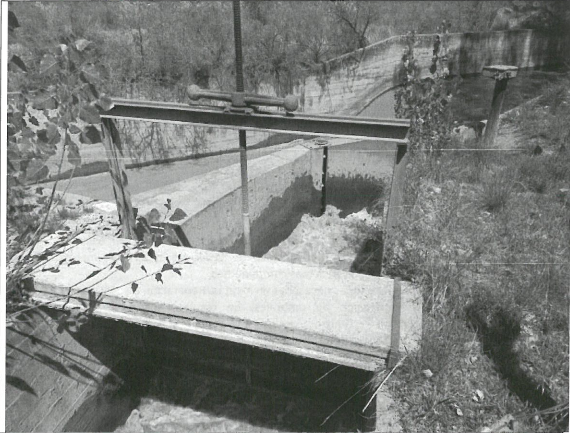
Comparto Manzano , compuesto por una hoja partidora y una compuerta de ataje.
