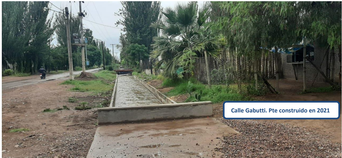
Figura Nº 2. Vista hacia Puente Calle Gabutti_Fin del tramo 1 de revestimiento
