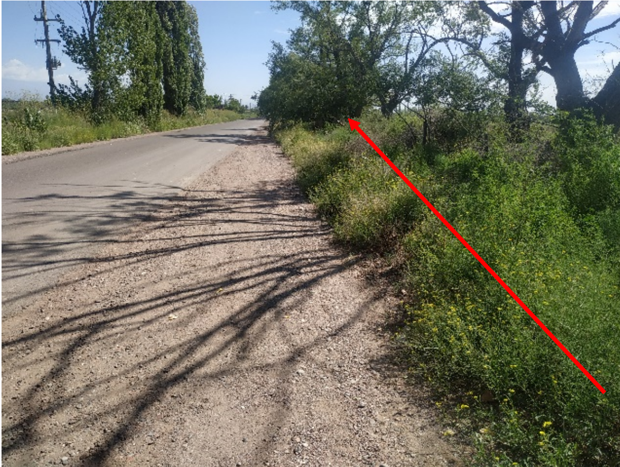
Figura Nº 16. Vista de Calle Clodomiro Silva. Margen derecha por donde irá el entubado
