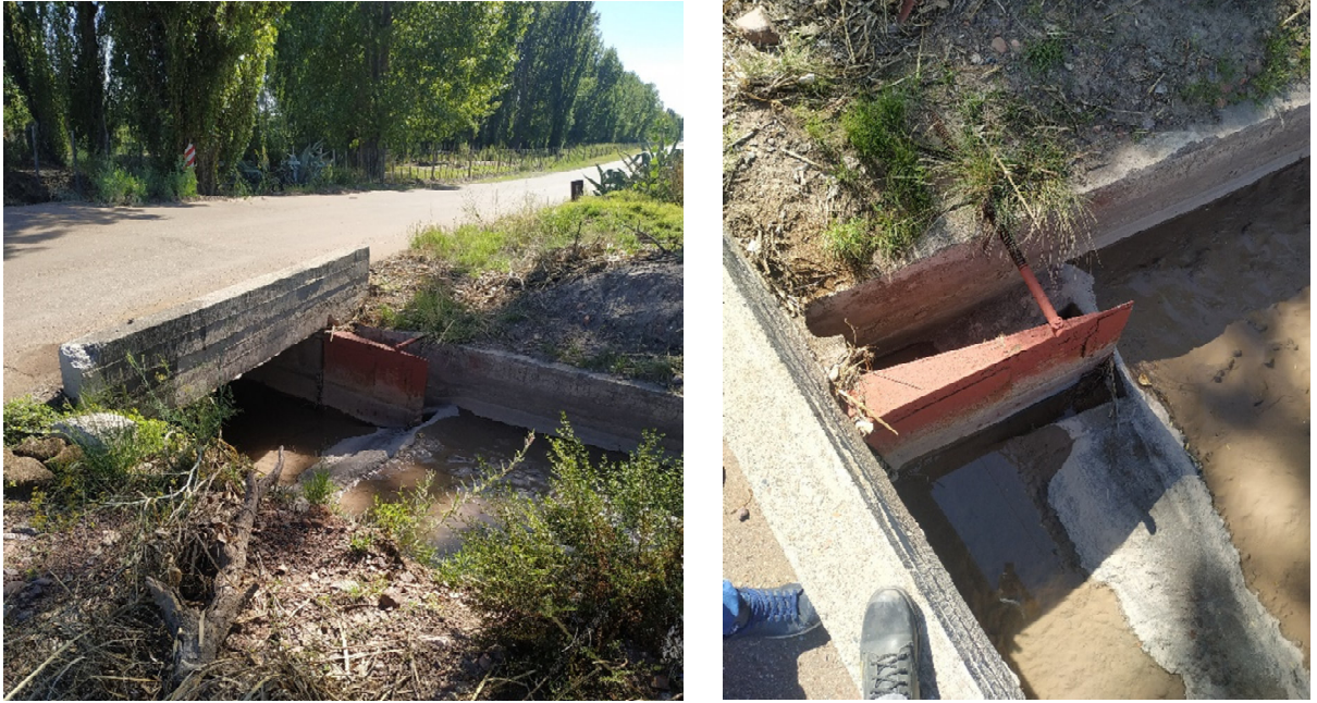
Figura Nº 4. Obra de Toma actual Hijueta Villalobos.
