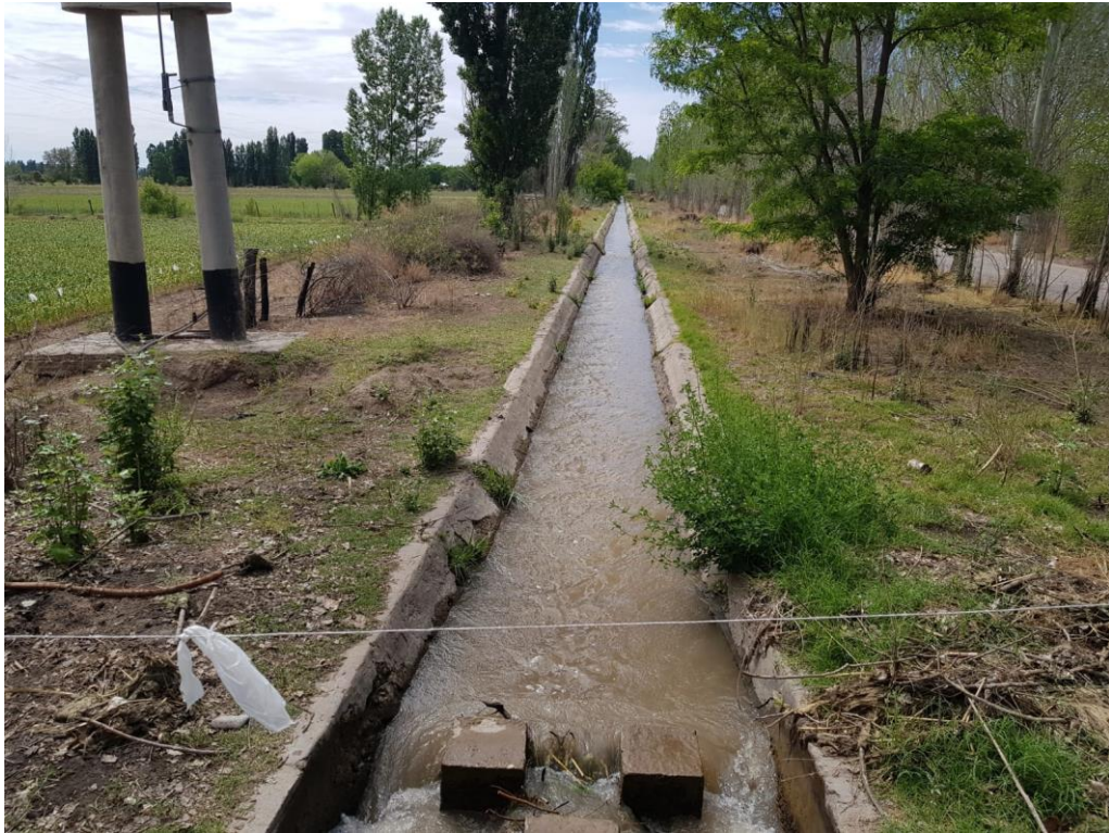
Figura N° 2. Tramo 200 m aguas arriba de proyecto. Último Tramo Revestido
