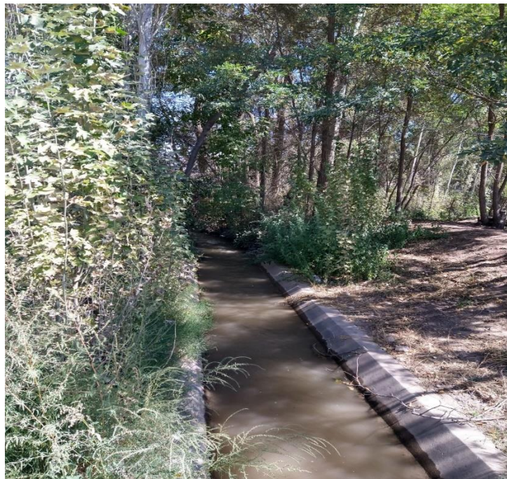
Figura N° 3. Inicio del Tramo a Revestir. Prog. 0+000.
