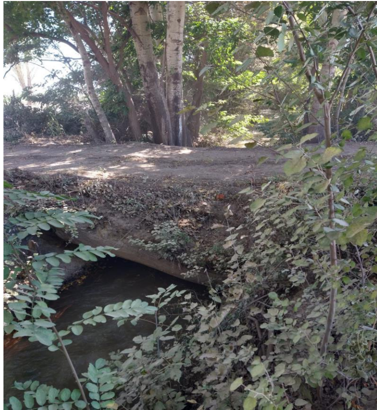
Figura Nº 4. Puente N°1. Prog 0+250.
