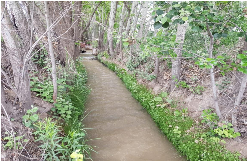
Figura Nº 5. Llegada al Primer Partidor. Puente y Obra N°3. Prog 0+069.
