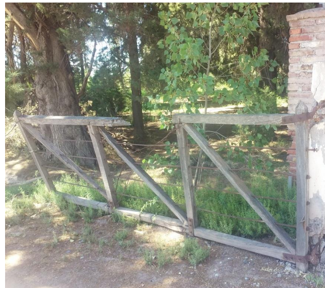
Figura 7: Provisión y colocación de postes y tranquera nueva de acceso en el camino al dique.
