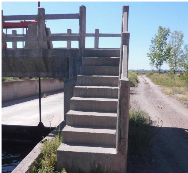
Figura 6: Se construirá puerta de rejas de acceso en escalera de acceso. El ancho de paso libre del marco de la reja, será igual al ancho de la escalera.
