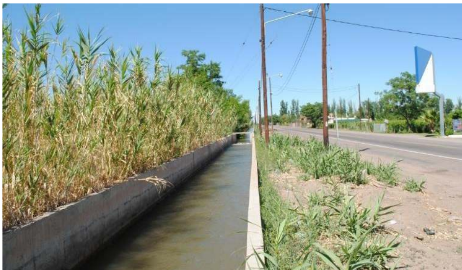
Figura N° 10. Rama Chimba. Sección revestida existente.
