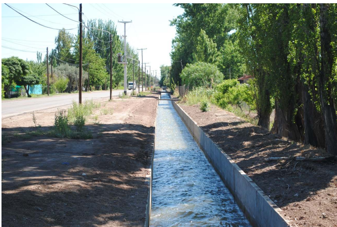
Figura Nº 23. Rama Chimba. Traza revestida existente.
