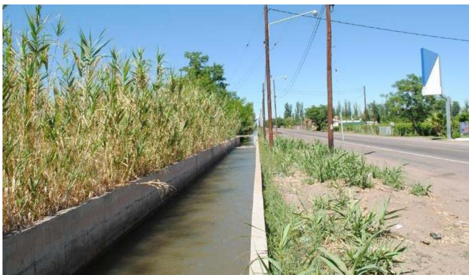
Figura N° 10. Rama Chimba. Sección revestida existente.
