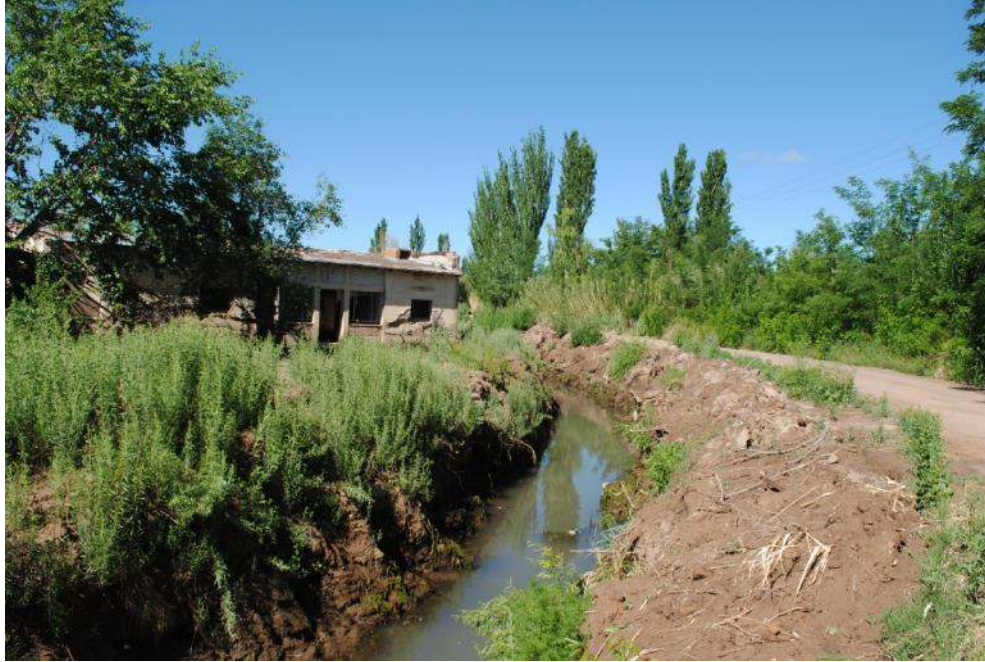
Figura N° 8. Rama Chimba. Sección sin revestir existente.
