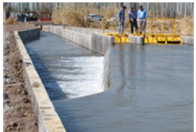
Figura 25: Derivación con pico de pato + módulo
