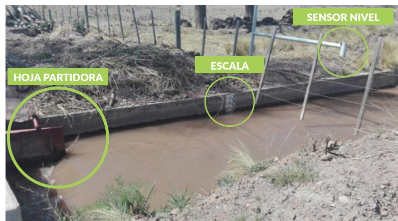
Figura 18: Partidor hijuela Villalobos y estación mido
