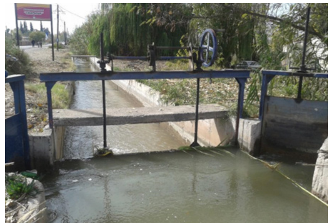
Figura 22: Compuerta baja altura Rama Chimba
