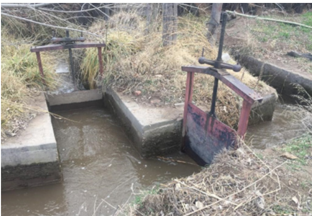
Figura 21: Derivación con compuertas planas
