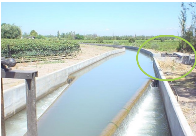
Figura 24: Pico de pato Canal Nuevo Retamo
