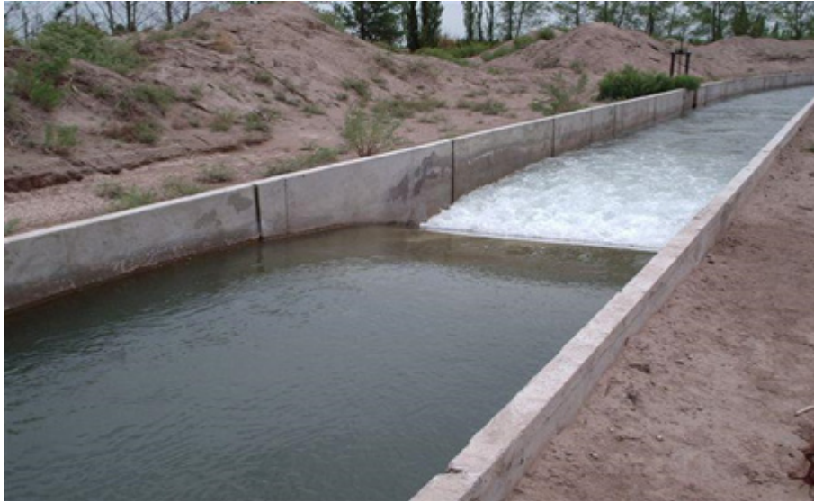
Figura 33: Sección de aforo en Canal Baja de Araujo
