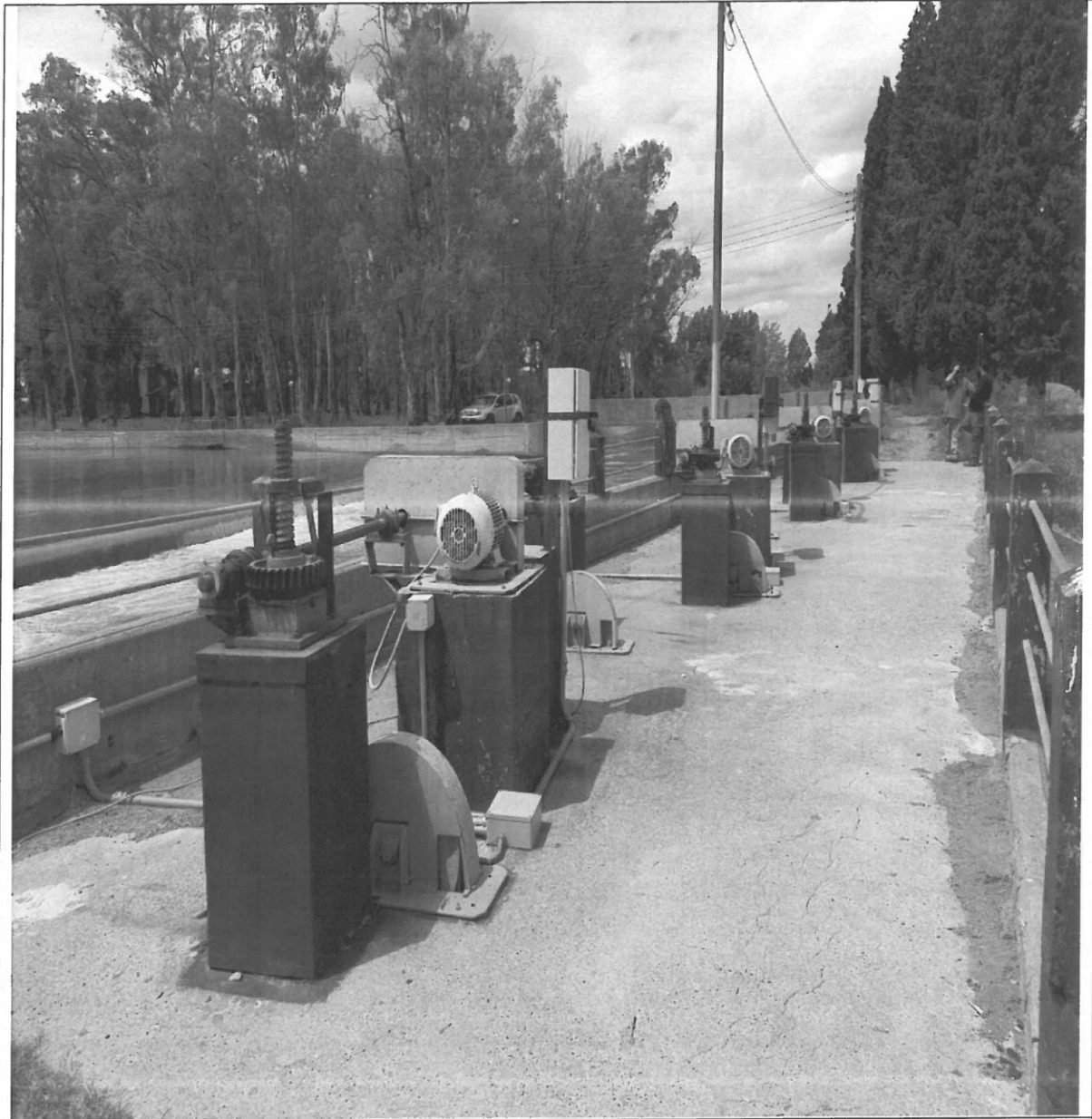
Cuadro de maniobra correspondiente a la Cámara Desarenadora del Dique Rincón del Indio (La Hoya)
