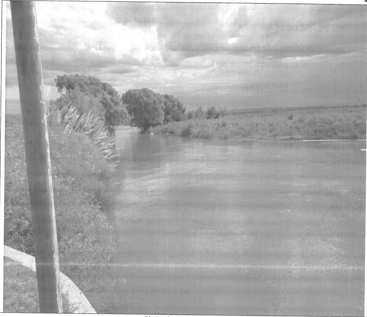
Río Atuel en la Obra de Toma
