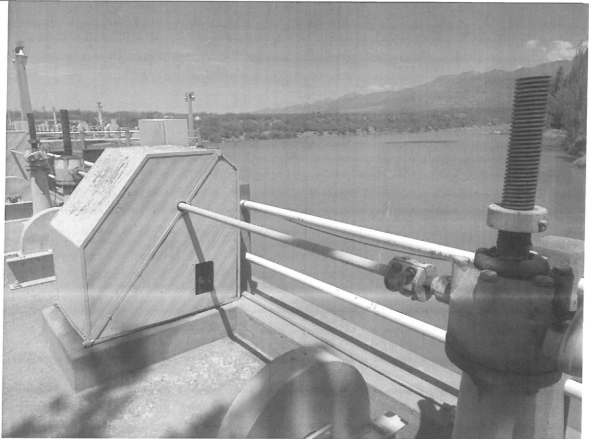
Dique valle de Uco en el Río Tunuyan.
