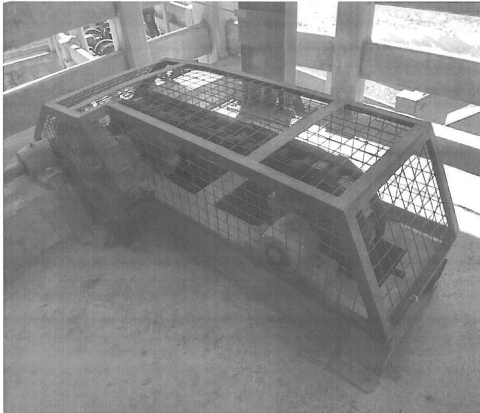
Provisión de materiales, armado y montaje de cobertores de protección en mecanismos. De acuerdo a diseño, de fácil remoción, con ventanas de acceso para lubricación de alemites y cadenas.
