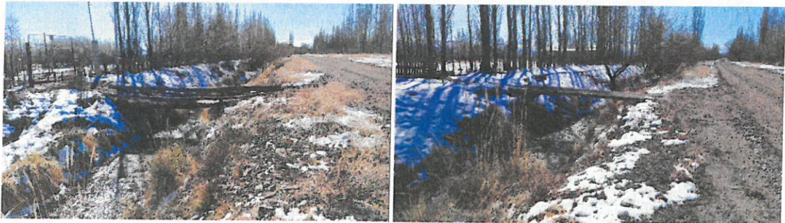
Puentes precarios existentes sobre el cauce
