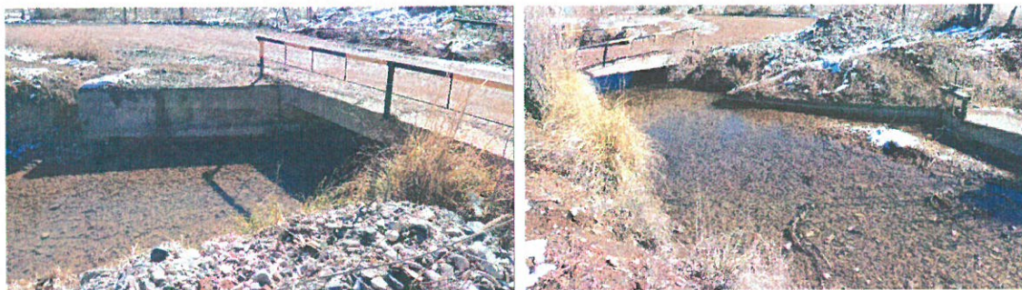
Final de obra – Puente Muñoz y Derivación (Pr. 0+ 1.405,61)
