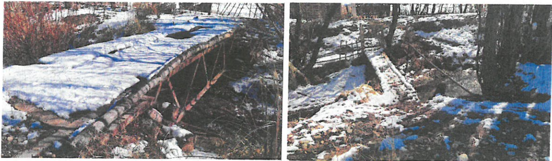
Puentes precarios existentes sobre el cauce
