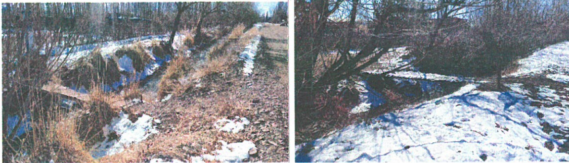
Puentes precarios existentes sobre el cauce
