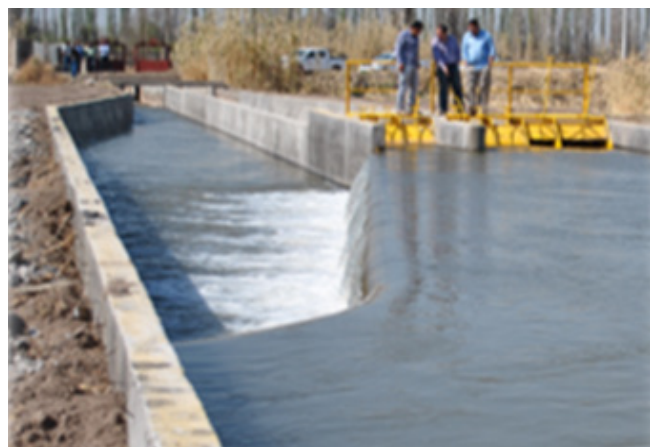
Figura 25: Derivación con pico de pato + módulo
