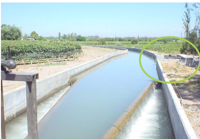
Figura 24: Pico de pato Canal Nuevo Retamo
