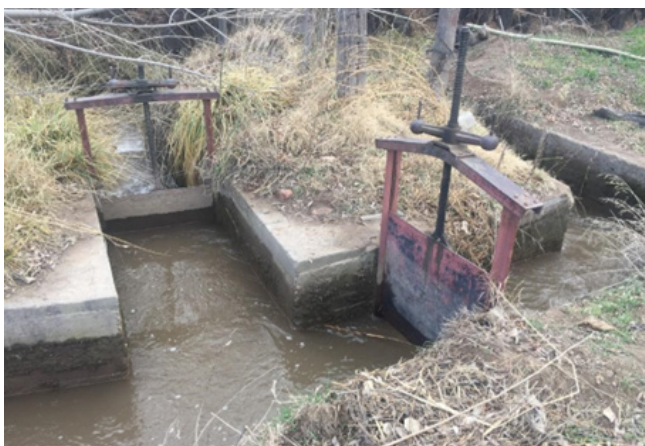
Figura 21: Derivación con compuertas planas
