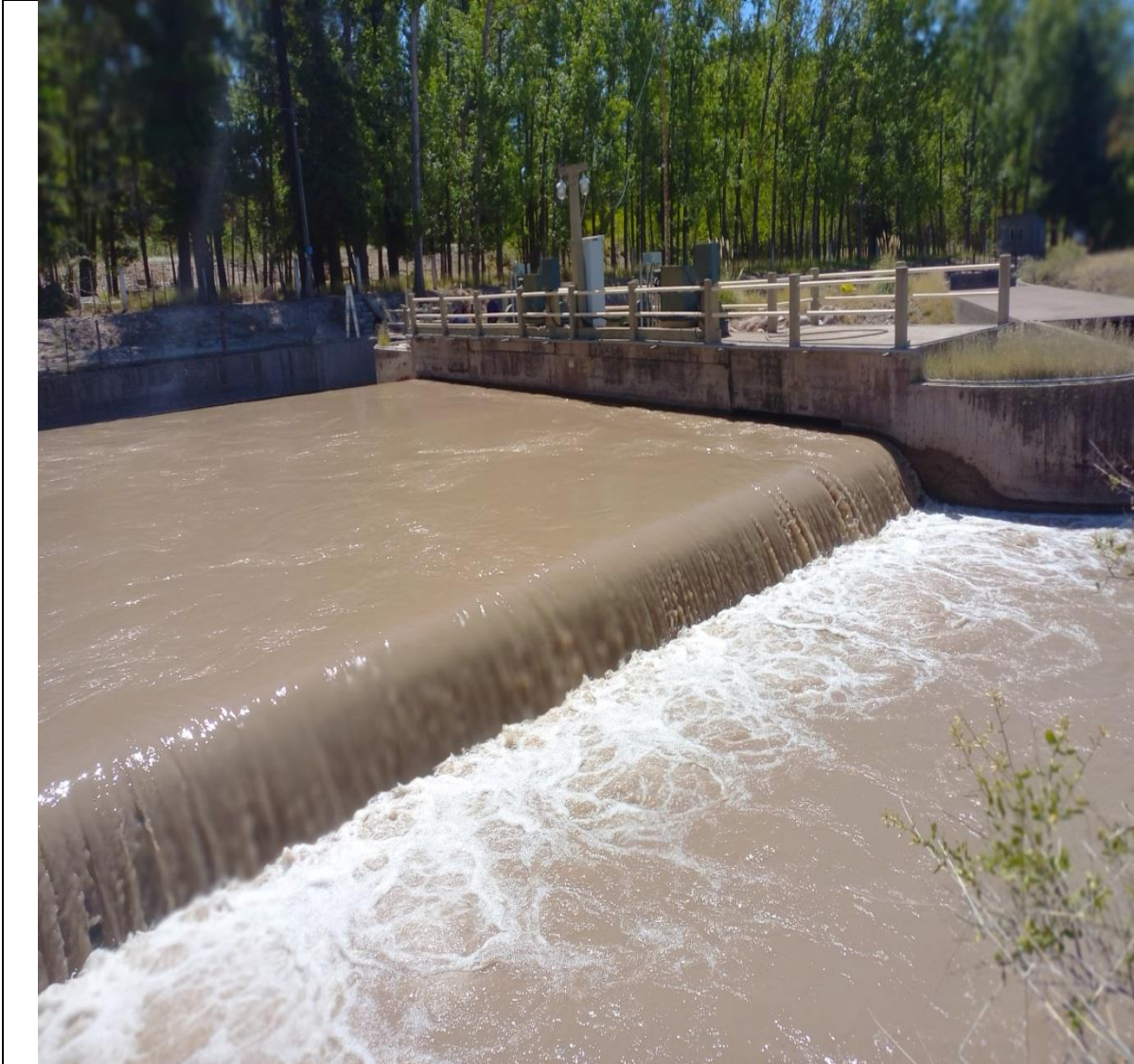
Las dos compuertas recibirán reparación integral.
