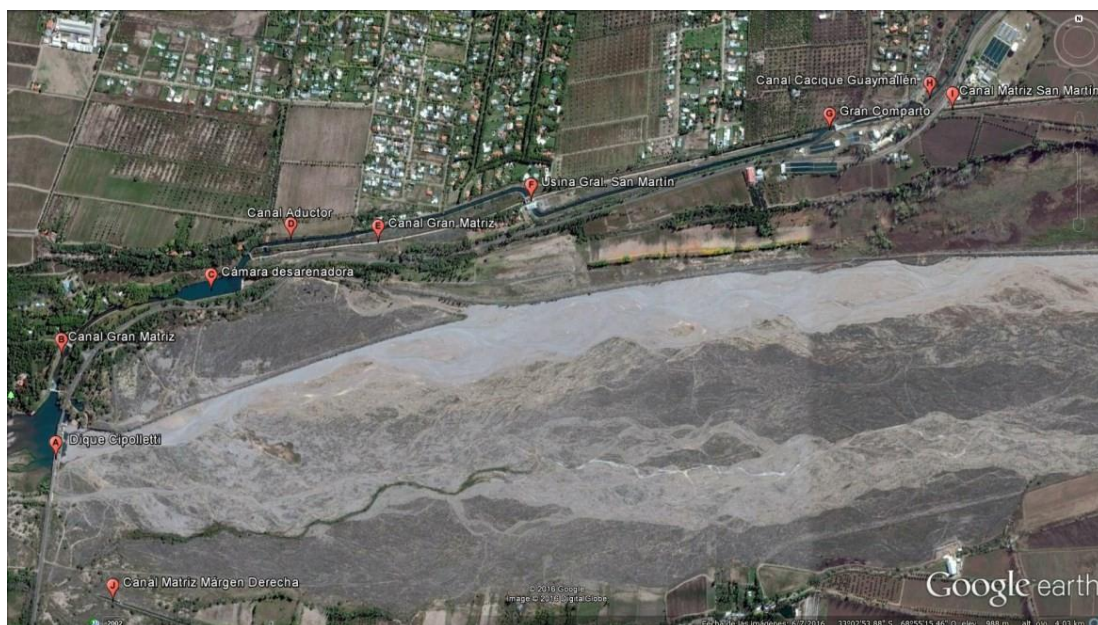
Ilustración 46 Imagen de la disposición de los principales canales derivados del dique Cipolletti.
